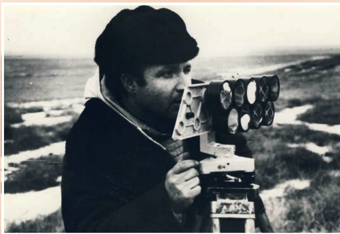
1976 г. Омская область. Наконец-то линии можно измерять светодальномером 2СМ2. Кацман И.Ф.
